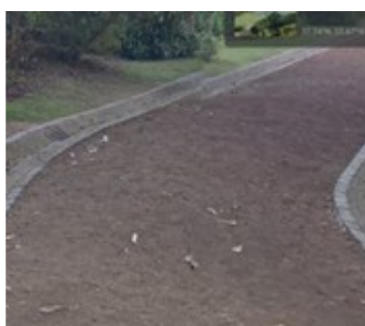
Figura 22: Degradação e erosão do solo.
